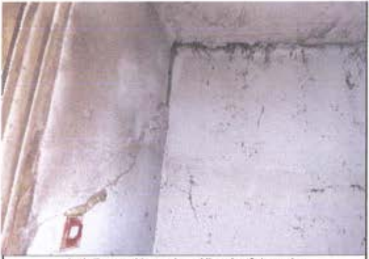
belső repedés szoba-előszoba falzatán
